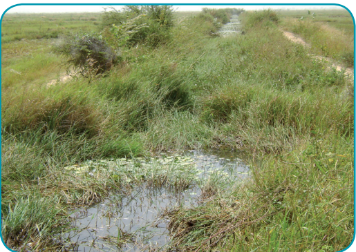
Photo : Exemple d'enherbement excessif d'un canal arroseur.
