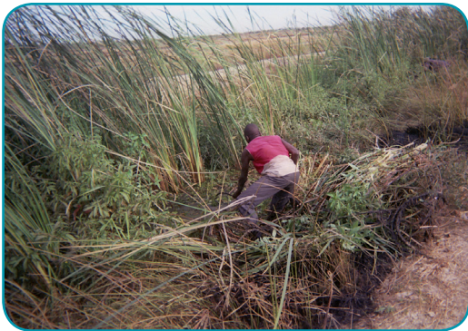
Photo : Enherbement et engorgement complet d'un drain tertiaire.
