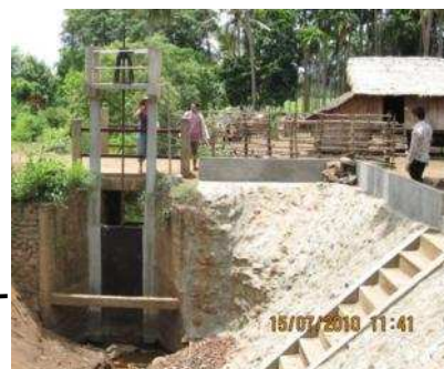
Porte d'eau du réservoir de Phum Bey
