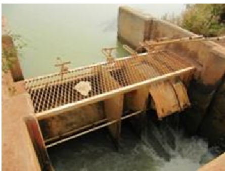
Système de « module à masque » qui permet avec beaucoup d'aisance de contrôler le débit en fonction des besoins d'irrigation
