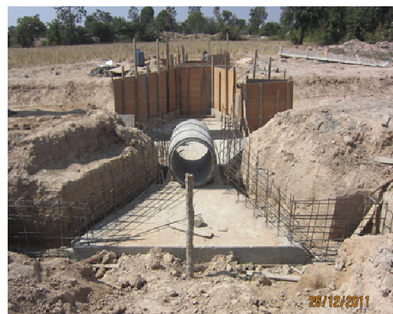
Avancement de la première structure de contrôle
