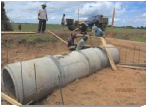
Stung Chinit North: Construction d'une conduite le long de SC3 – TC B4 et empierement pour une structure de contrôle sur le SD3
