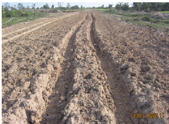
Digue du canal après inondation
