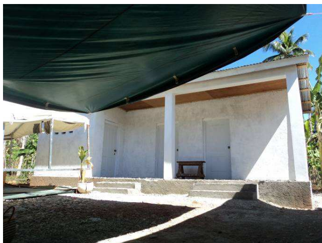
Photo 3 : Local de la BIA, finitions en cours
