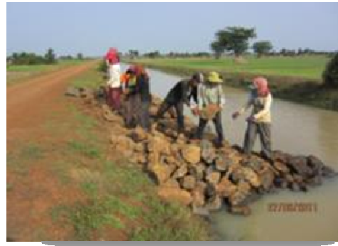
Stung Chinit North: Construction d'une conduite le long de SC3 – TC B4 et empierement pour une structure de contrôle sur le SD3
